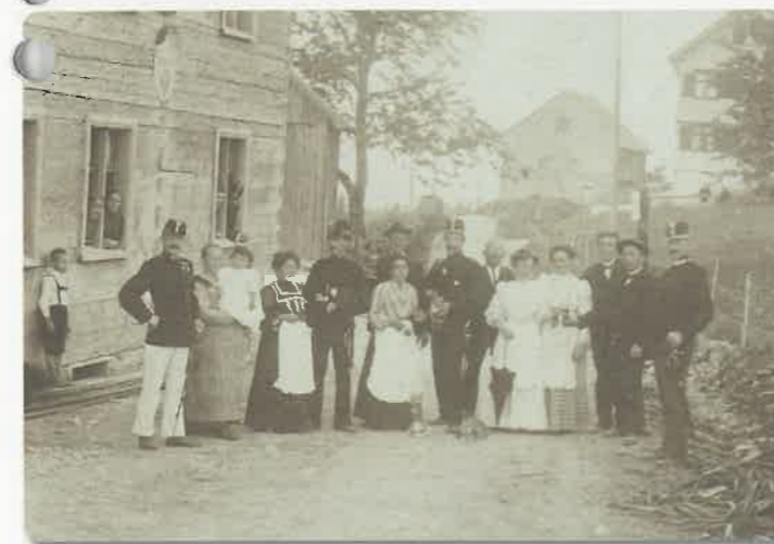
Die Zollwache mit illustrier Damengesellschaft im Jahr 1906, damals untergebracht im Haus Nr. 14 (jetzt Irmgard und Werner Mennel).
