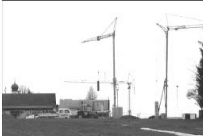
Bagger und Kräne haben heuer Hochbetrieb in Sulzberg.
