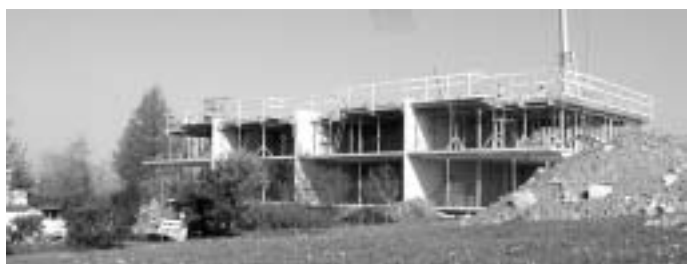
Die Wohnanlage in Oberdorf mit 9 Wohnungen ist im Rohbau fertig. Alle Wohnungen wurden an Einheimische verkauft.
