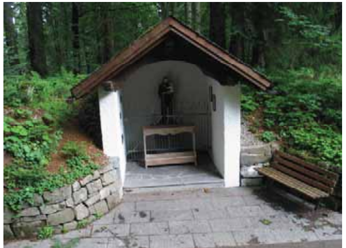
St. Josefskapelle im Altenwohnheim Sulzberg
