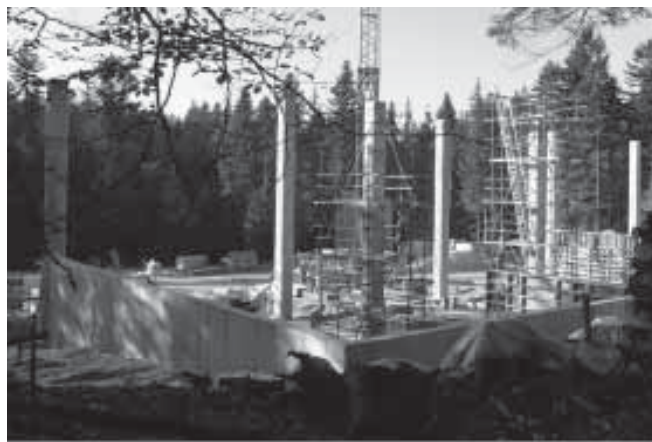
Im Pfarrwald an der Zollstraße entsteht die neue Hackgut-Lagerhalle
