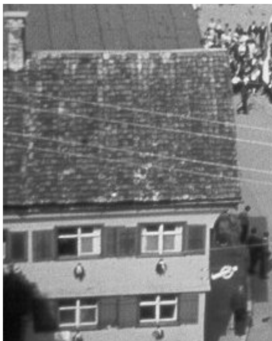
Kaplanhaus St. Leonhard Westseite
