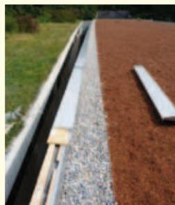
Beim Bau der 2. Röhre des Pfändertunnels wurden wir mit sämtlichen Verblechungsarbeiten beim Betriebsgebäude sowie an den Nord- und Südportalen beauftragt. Die extensive Dachbegrünung bei den beiden Portalen mit einer Gesamtfläche von ca. 2400m<sup>2</sup> haben wir ebenfalls durchgeführt.
