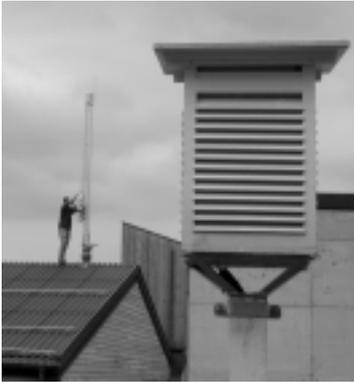
Laufend wird gemessen: Lufttemperatur, Rel. Feuchte, Luftdruck, Niederschlag, Sonnenscheindauer, Globalstrahlung, Windgeschwindigkeit, Bodentemperatur, Taupunkt, Schneehöhe, Windrichtung, Böespitzenwerte, Himmelstrahlung. Die Wetterstation besteht aus bodennahen Geräten nordseitig vom Gemeindehaus, aus einem Geräteträgermast auf dem Feuerwehrgerätehaus und einer
